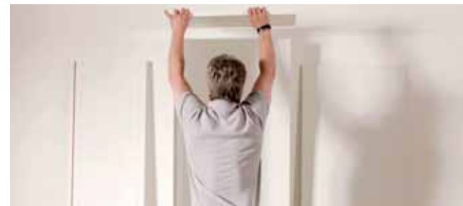
Deckel aufsetzen und zur Möbelseite schieben.
