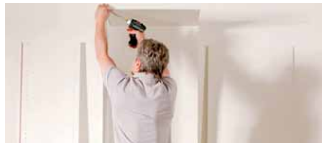
Akkuschauber bereithalten und vordere Ecke verschrauben. So sind auch Einmannmontagen problemlos möglich.
