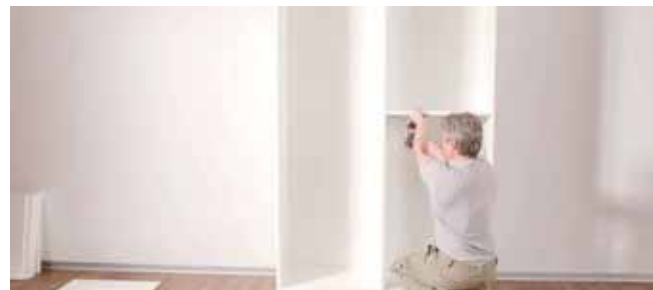
Tipp: – Boden einseitig auf Tablarträger legen und andere Seite befestigen – Bündig zurückgedrehte Schrauben erleichtern den Einbau.
