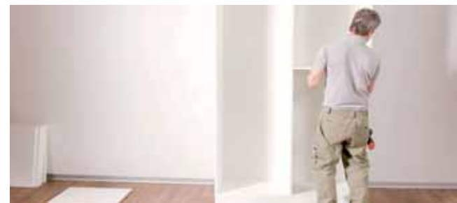
Nach dem Zusammenbau die fixen Zwischenböden an den gewünschten Positionen befestigen.
