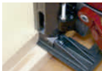
Reparatur im Falz
