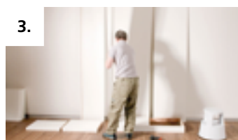
3. Placer le côté du meuble sur le socle. L'élément est directement positionné correctement grâce à la vis saillante
