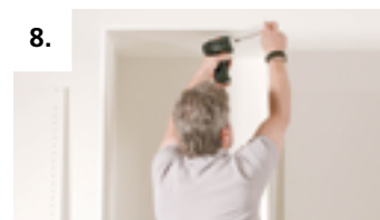
8. Assemblage des meubles terminé et montage ultérieur des fonds intermédiaires fixes
